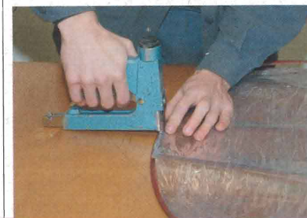
10. Die Klammern des Tackers müssen am schmalen Rand des oberen Fensterrahmens sehr präzise gesetzt werden.
