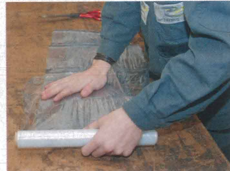
5. Zum Schutz vor Kratzern während des Einnähens wickelt der Auszubildende das neue Fenster mit Frischhalte-Folie ein.
